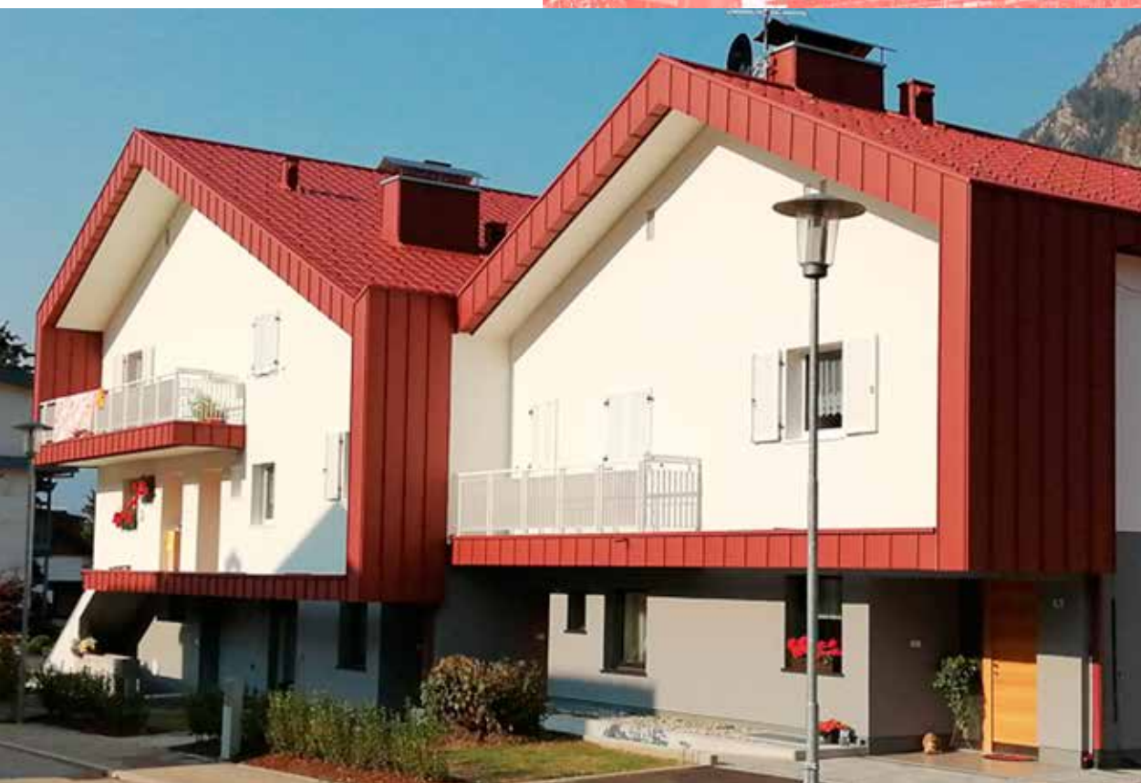
Sopra, in rosso: Bolzano, riqualificazione energetica fabbricato residenziale IPES
